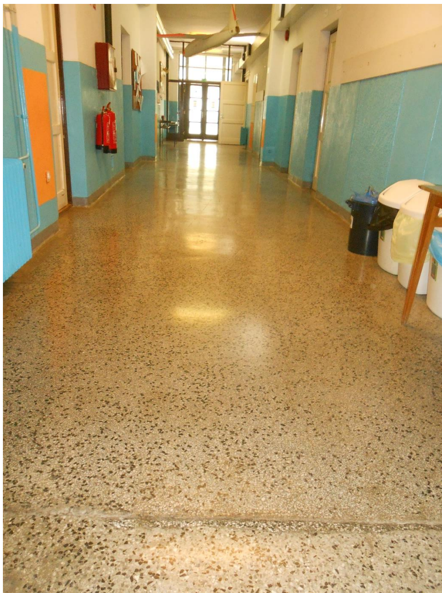
Slika šte. 9: prečno razpokan teraco hodnika
