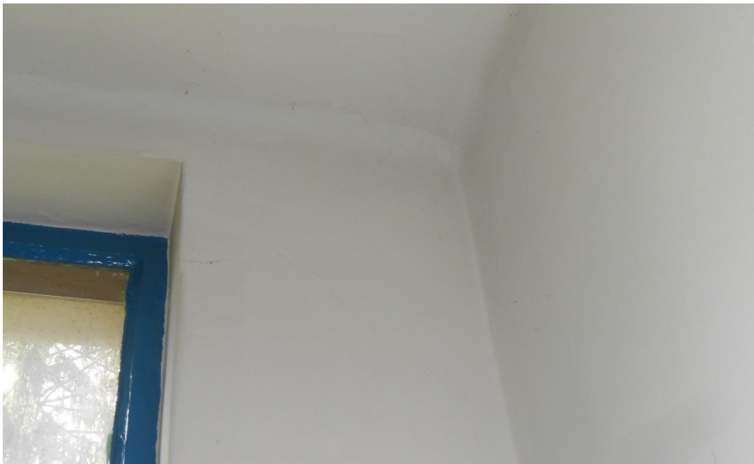
Slika šte. 8: fotografija razpok(e) od vogala okna v nadstropju čelne stene
