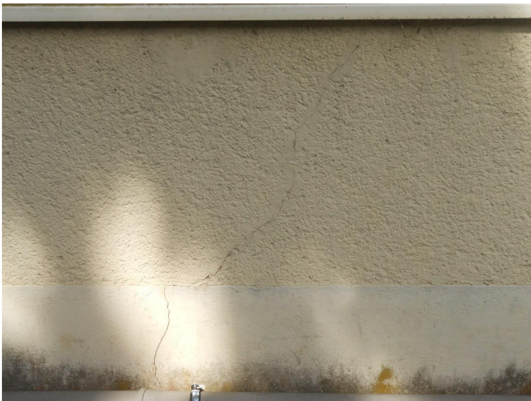
Slika šte. 4: razpoka zidnega nastavka vzdolžnega fasadnega zidu
