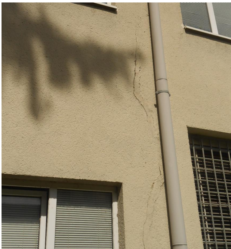
Slika šte. 6: navpična razpoka na stiku oziroma v vogalu prečnega zidu ob pozidanem stebrišču
