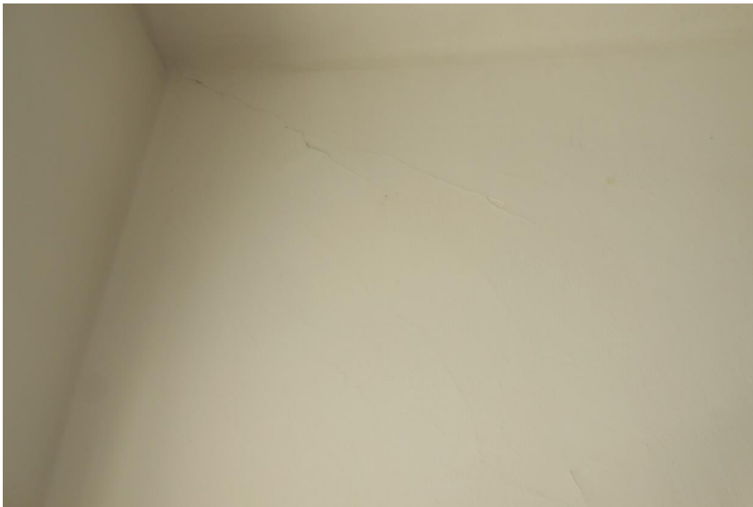
Slika šte. 7: fotografija poševne strižne razpoke zidu
